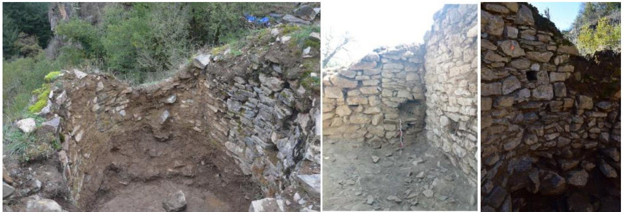
Fig. 9 : Château de La Roque (81), tour en cours de déménagement. On aperçoit le reste de maçonnerie du mur (MUR16) au fond.
